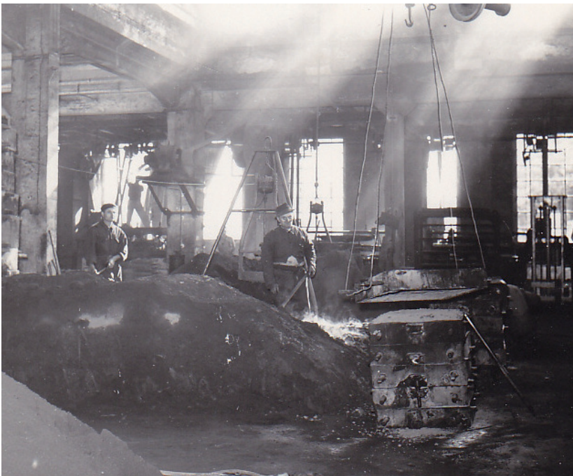
Uno scorcio della vecchia fonderia
