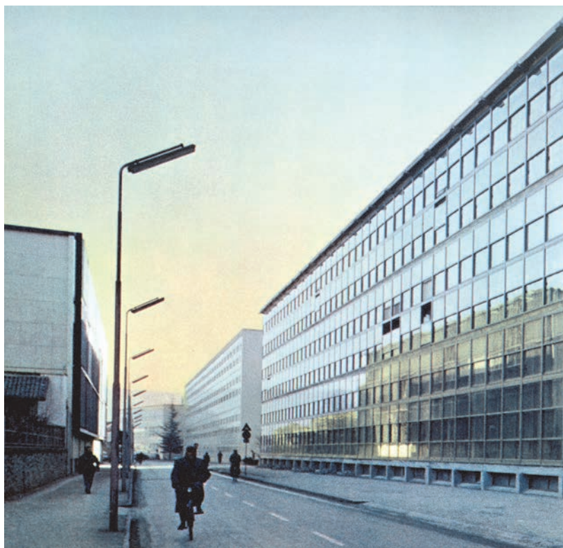
Via Jervis - Stabilimenti Olivetti
