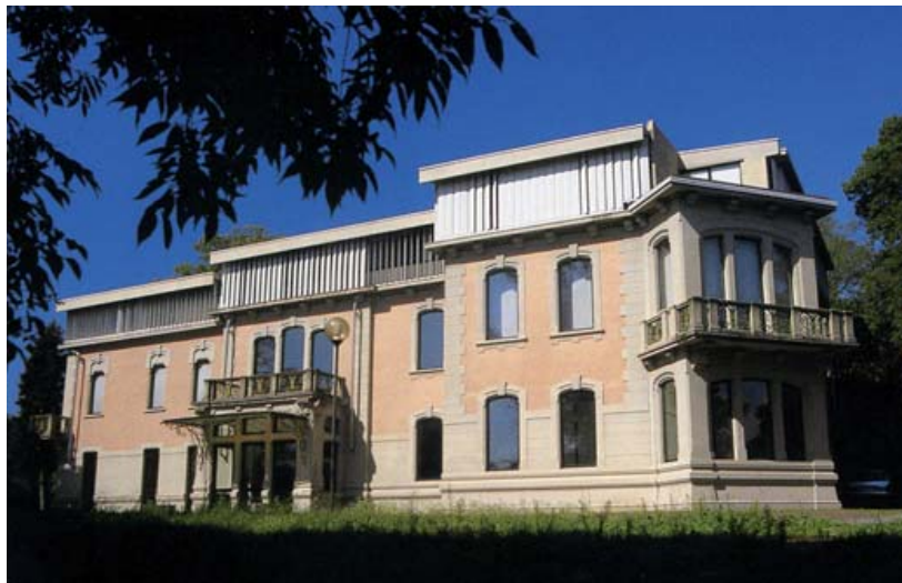
Una panoramica di Villa Casana, sede dell'Archivio storico Olivetti
