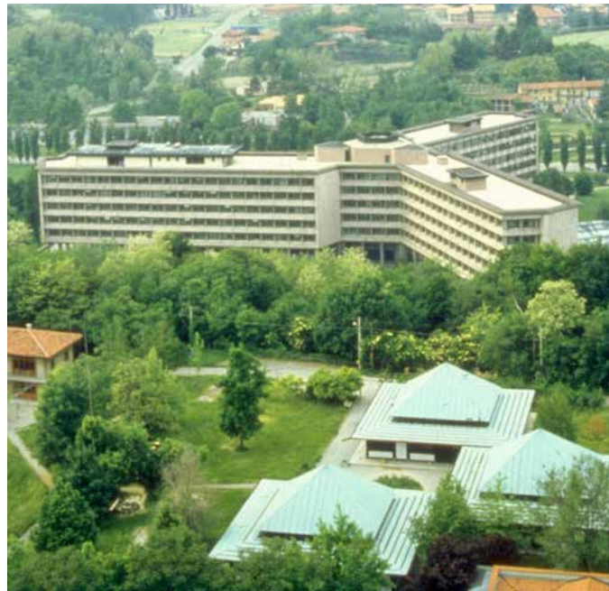
Due belle immagini del "Palazzo Uffici" progettato, negli anni 60 del Novecento, dagli architetti: Gian Antonio Bernasconi, Annibale Focchi e Marcello Nizzoli, da tempo legati all'Olivetti.
